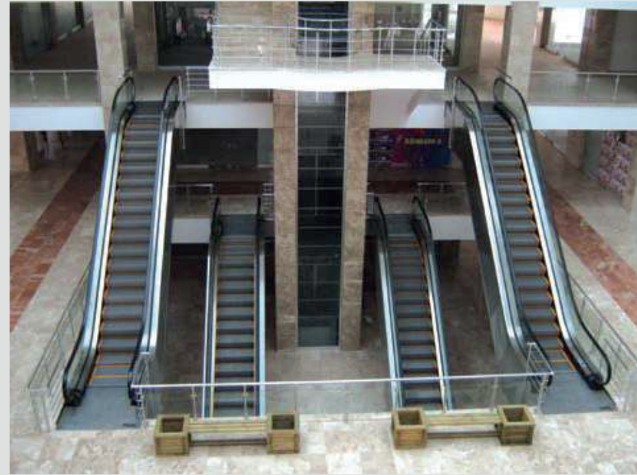
Yer : Antalya MYRA AVM Yapıldığı Tarih : 2007 Yükseklik : 3700 mm. Açı : 35 Basamak genişliği : 1000 mm.
