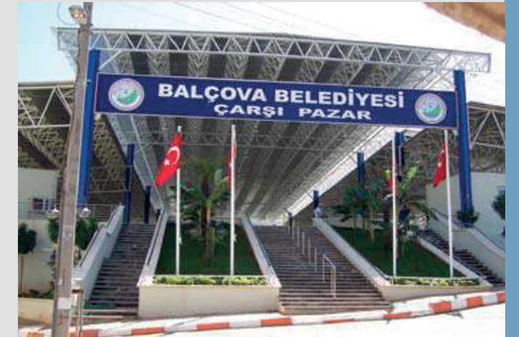
Yer : İzmir Balçova Pazar Yeri Yapıldığı Tarih : 2006 Teknik özellikleri : Yükseklik : 4500 mm. Açı : 12 Basamak genişliği : 800 mm.
