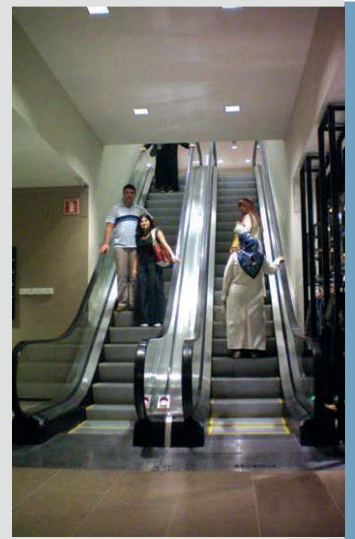
Yer : İstanbul History AVM - Zara Mağazası Yapıldığı Tarih : 2008 Teknik özellikleri : Yükseklik : 4500 mm. Açı : 35 Basamak genişliği : 800 mm.
