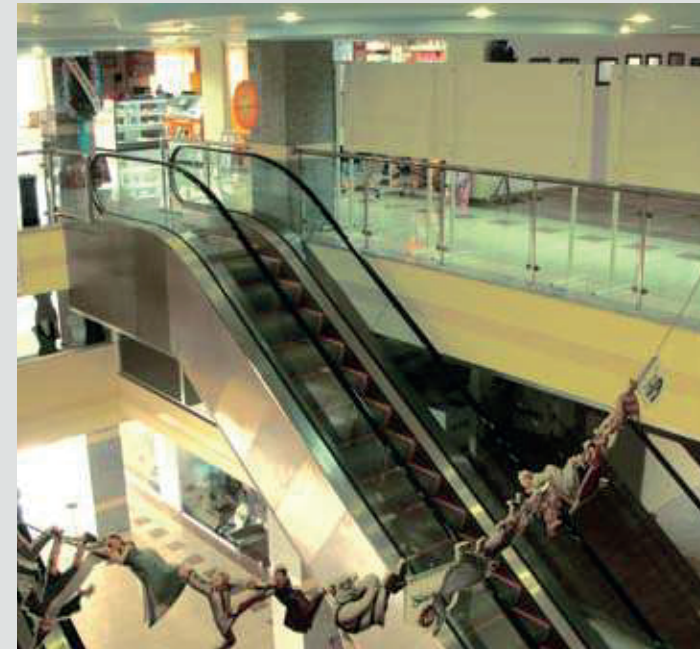
Yer : Altınoluk Molida AVM Yapıldığı Tarih : 2005 Teknik özellikleri : Yükseklik : 6000 mm. Açı : 35 Basamak genişliği : 800 mm.
