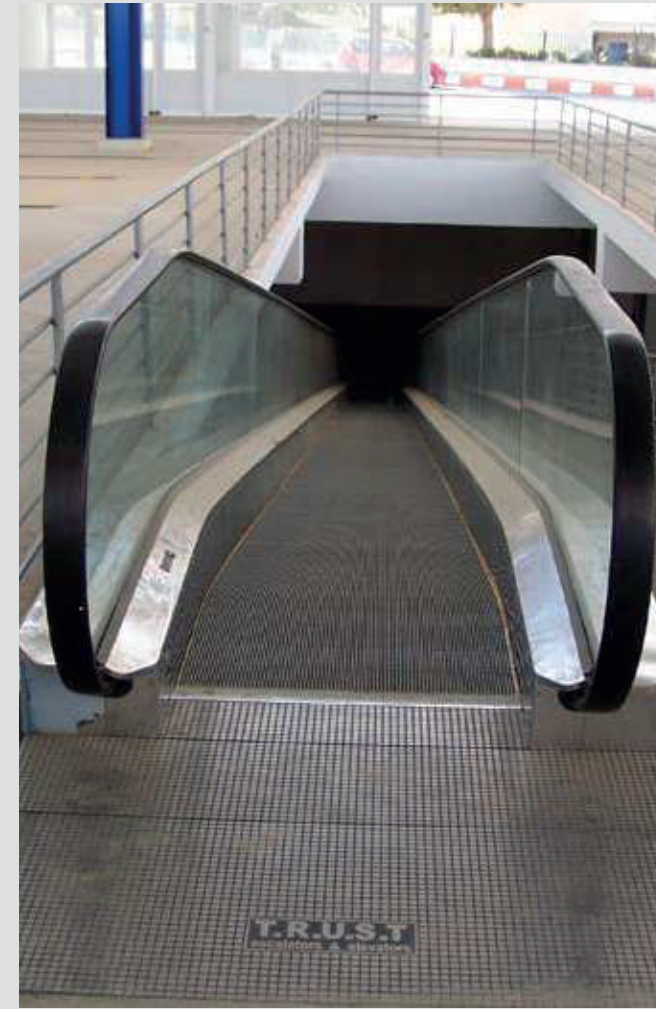
Yer : İzmir Balçova Pazar Yeri Yapıldığı Tarih : 2006 Teknik özellikleri : Yükseklik : 4500 mm. Açı : 12 Basamak genişliği : 800 mm.
