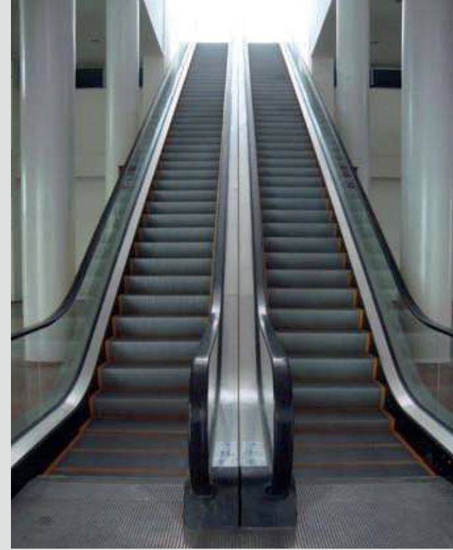
Yer : Ankara Platin Mobilya Mağazası Yapıldığı Tarih : 2006 Teknik özellikleri : Yükseklik : 8200 mm. Açı : 30 Basamak genişliği : 1000 mm.
