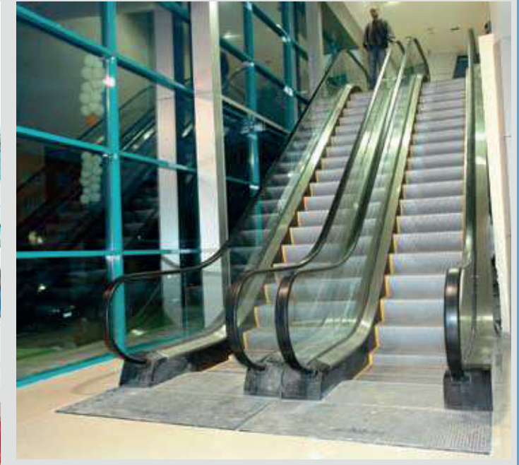
Yer : Karum AVM Uşak Yapıldığı Tarih : 2006 Teknik özellikleri : Yükseklik : 4200 mm. Açı : 35 Basamak genişliği : 800 mm.
