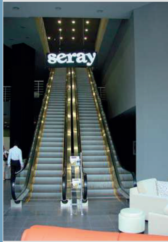
Yer : Yalova Otobüs Terminali Yapıldığı Tarih : 2007 Teknik özellikleri : Yükseklik : 8500 mm. Açı : 30 Basamak genişliği : 1000 mm.
